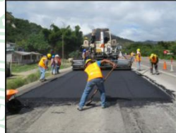
Pavimentar una carretera
