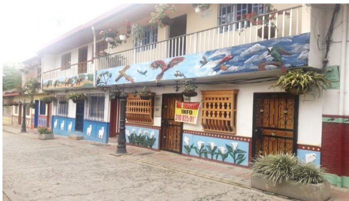
Figura 8. Zócalos en balcones. 50
