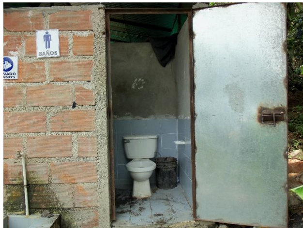
Imagen 4. “Zona de servicio sanitario”
