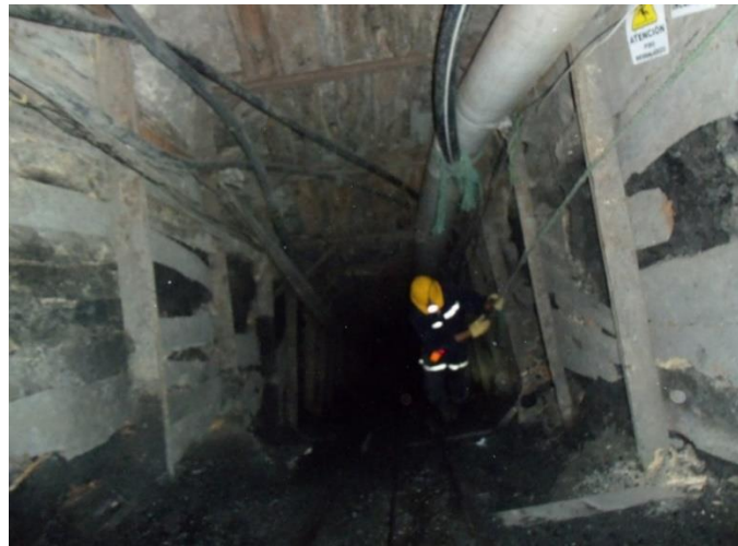
Imagen 12. Inclinación de galerías
