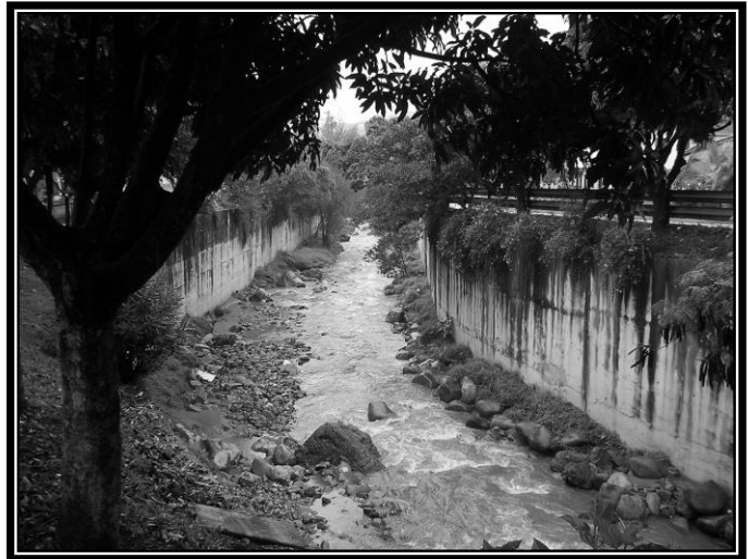
6. Canalización en la parte baja de La Ayurá, 2006. Fotógrafo: Mauricio Agudelo.
