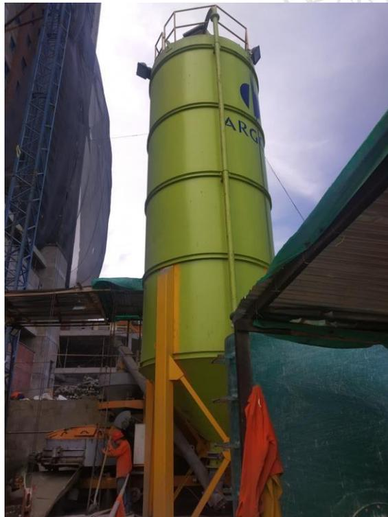
**Figura 4.** Almacenamiento de cemento a granel en silo de Argos. **Fuente: Propia.**
