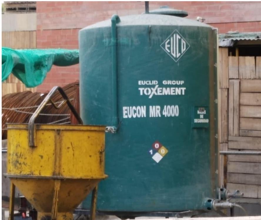
**Figura 9.** Isotank de almacenamiento del aditivo EUCON MR-4000. **Fuente:** Propia
