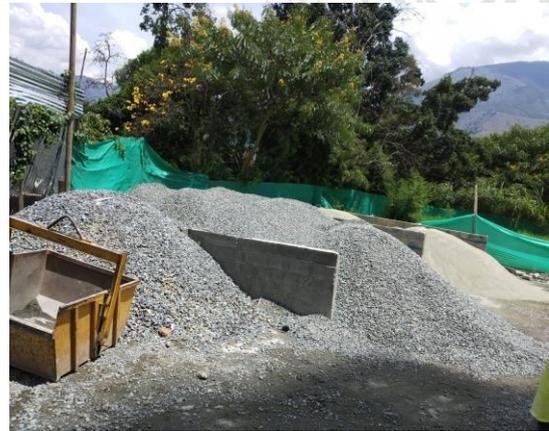
**Figura 2.** Agregado grueso y fino respectivamente almacenados en obra por medio de chiqueros. **Fuente:** Propia
