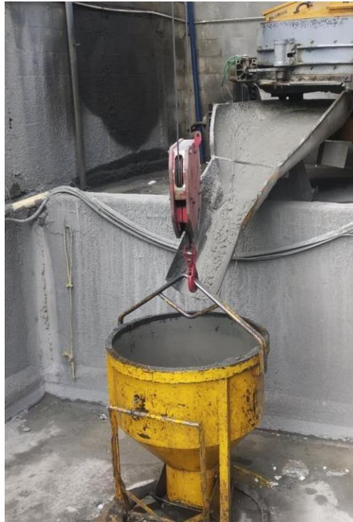
**Figura 16.** Transporte vertical del concreto por medio de la torre grúa y un bache. **Fuente:** Propia.
