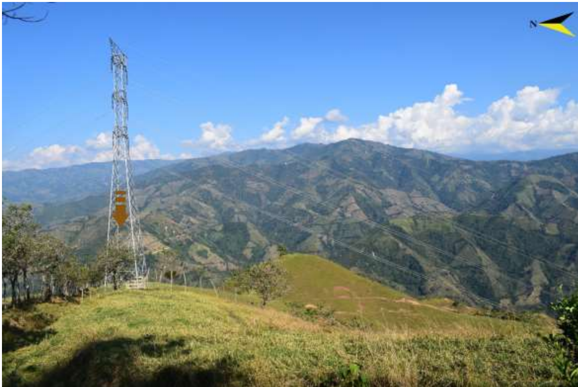
Fotografía 156. Huella de guaquería en torre de energía. Fuente: Elaboración propia.
