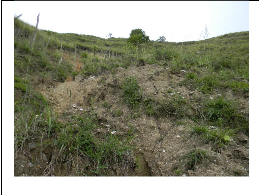
Fotografía 2. Deslizamiento de tierra por el Plan. Fuente: Elaboración propia.
