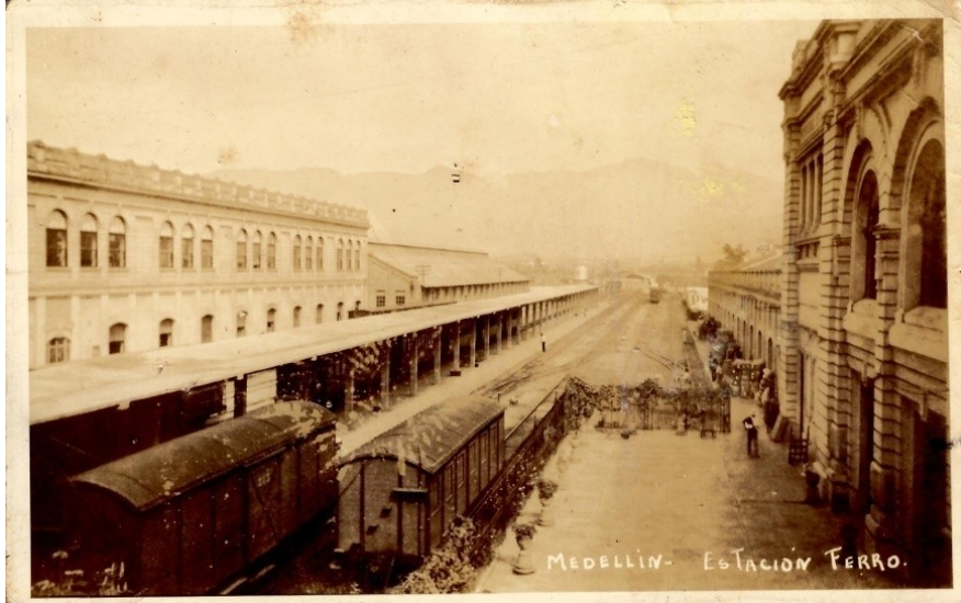
Figura 37. Postal: Estación del Ferrocarril de la ciudad de Medellín, (s. f.)
