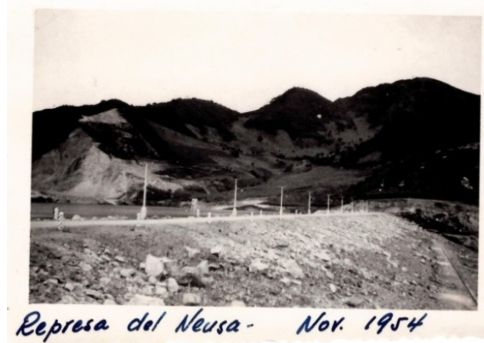
Figura 74. Represa del Neusa en zona montañosa sobre el río Neusa, (Circa 1964)
