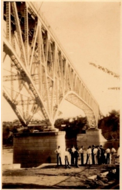
Figura 73. Grupo de egresados de la Escuela Nacional de Minas, posando al costado del puente de Girardot (Cundinamarca), (Circa 1935)
