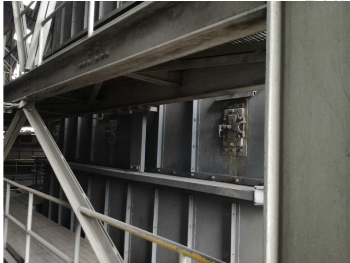
Figura 20. Accesos frontales de la caldera 4.
