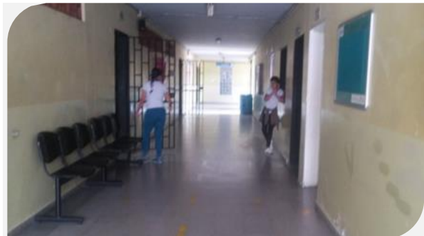
Imagen 19. Corredor del segundo piso
