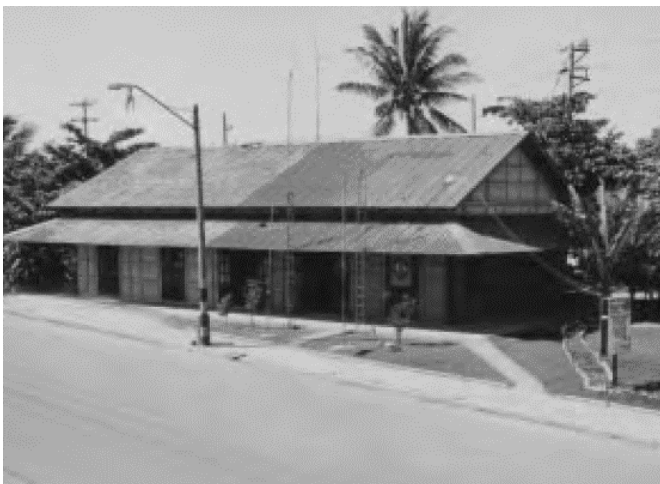
Figura 39. Edificio terminal ferrocarriles de Puerto Plata, R. D
