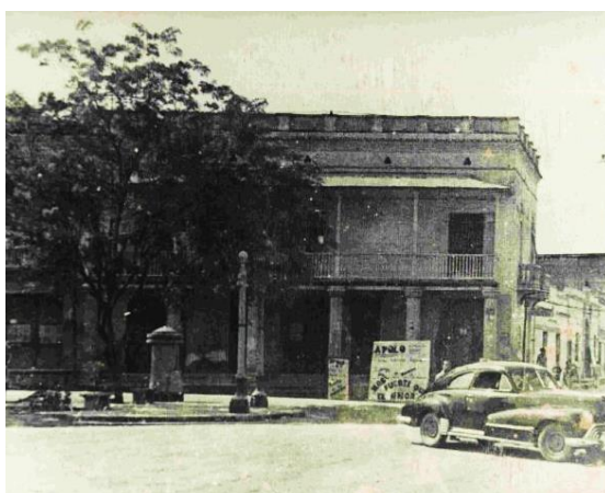
Figura 132. Edificio Club Sincelejo.
