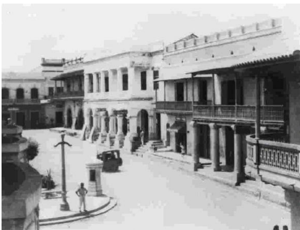
Figura 132. Edificio Club Sincelejo.
