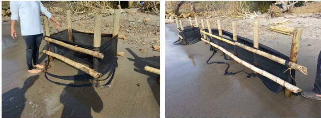
Figura 9. Evidencia del desgarro del polisombra en la estructura
