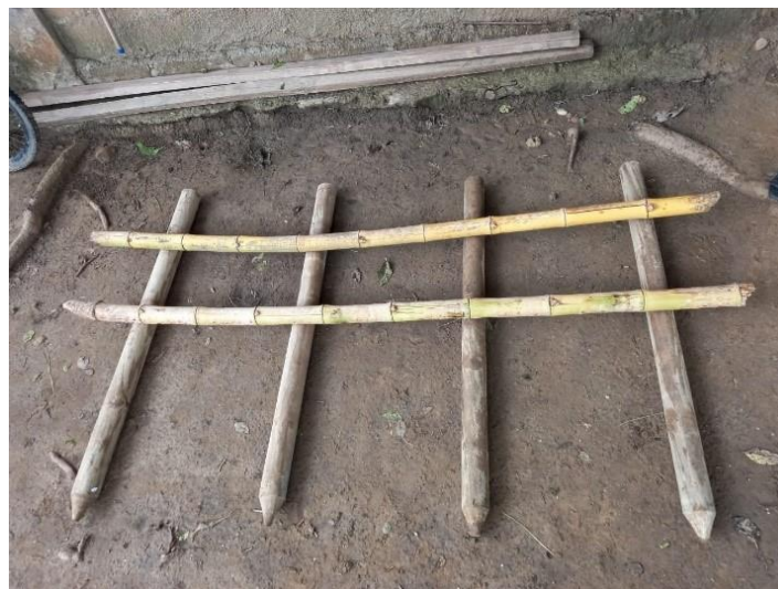
Figura 5. Postes de pino inmunizado usado como sustitución de las guaduas verticales. Se observan guaduas horizontales de menor calibre usadas para amarrar la estructura.
