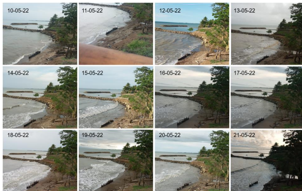
Figura 12. Monitoreo de la estructura y la evolución del depósito de sedimentos del 10 al 5 mayo del 2022
