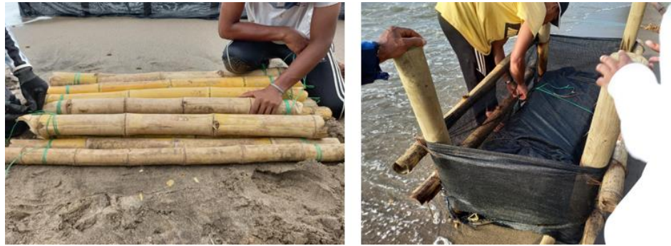
Figura 11. Amarre e instalación del relleno de la parte 1 de la estructura
