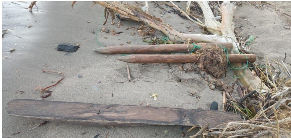
Figura 6. Postes arrojados fuera del agua por la energía del oleaje
