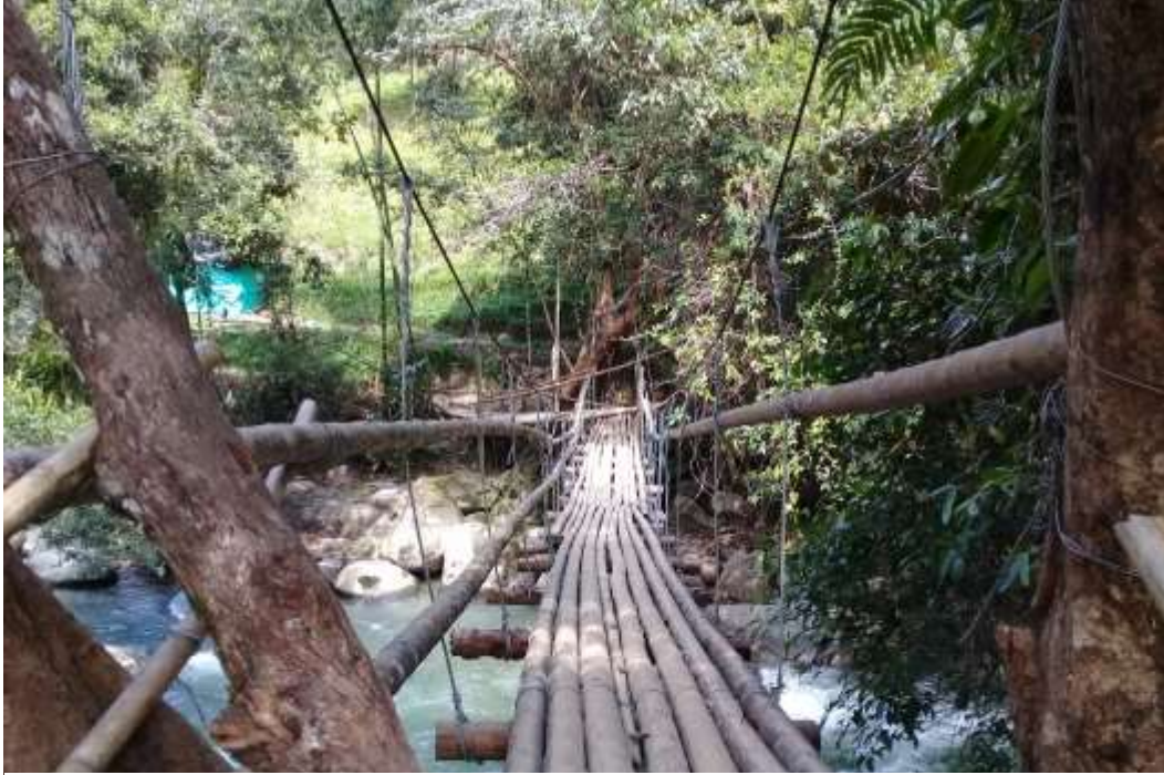
Figura 6. Puente de guadua sobre el río San Pedro que sirvió como paso improvisado durante casi dos años, cuando una avalancha tumbó el puente que comunicaba al corregimiento con el municipio de Nariño. (2017)
