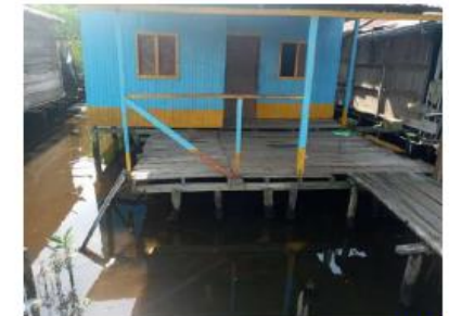
Pilotes construidos con mangle bobo
