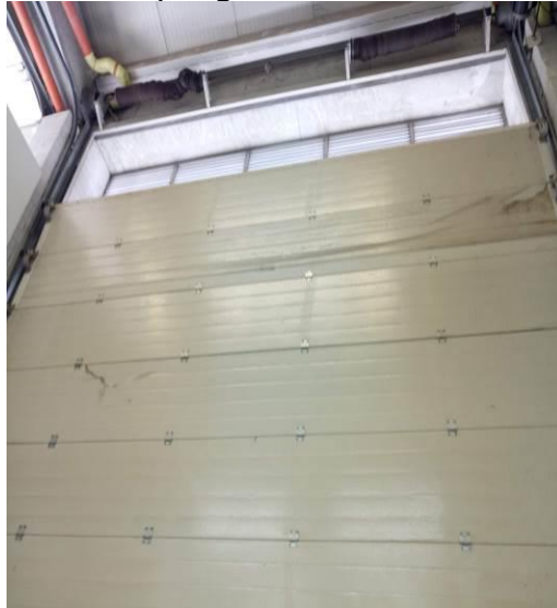
Figura13. Puerta Zona de Lavado
