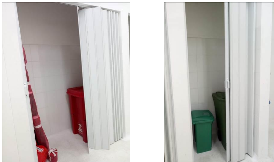
Figura12. Zona de Almacenamiento Temporal
