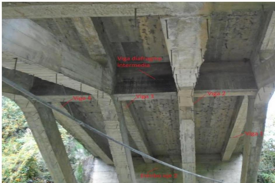
*Figura 12. Imagen de vigas, losa y riostras del puente Rio Grande.*
