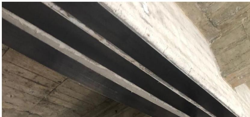
*Figura 7. Imagen de láminas de fibra de carbono instaladas a flexión en vigas.*
