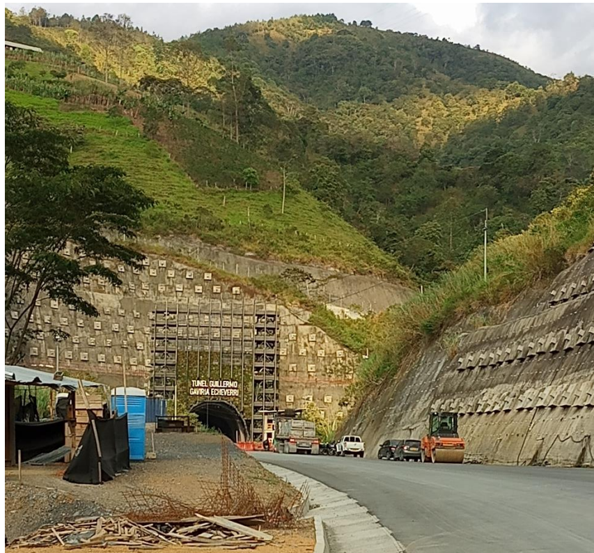
Construcción del TGGE, Buenos Aires-Parte alta
