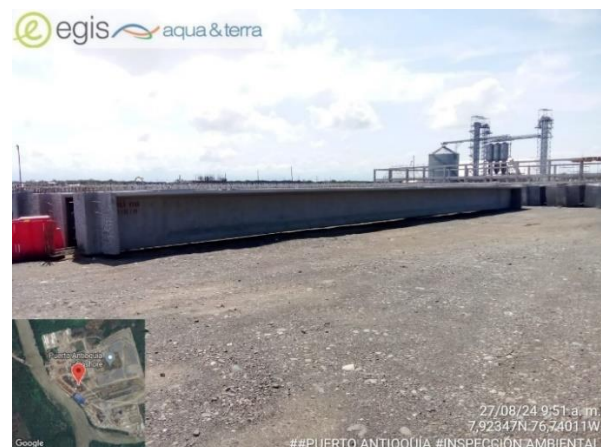
Figura 14. Vigas longitudinales para el viaducto.
