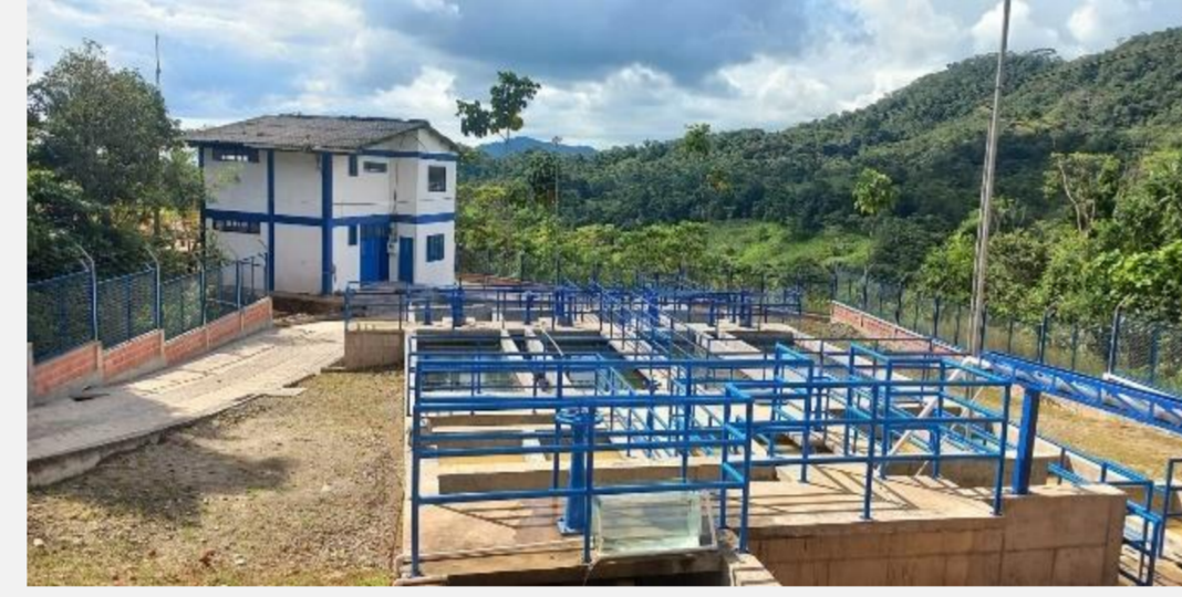
Figura 3. Nuevo tren de tratamiento de la PTAP La Mulata. Fuente: propia
