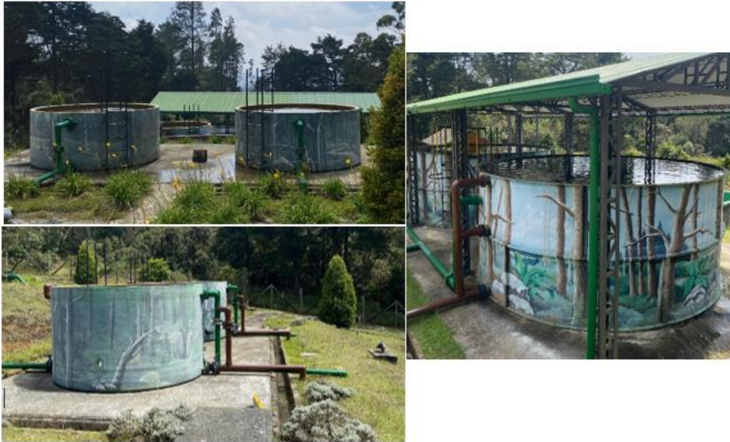
Ilustración 2: Sistema de filtración en múltiples etapas.
