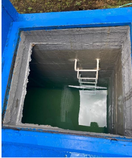
Ilustración 7: Tanque de almacenamiento acueducto Mazo.
