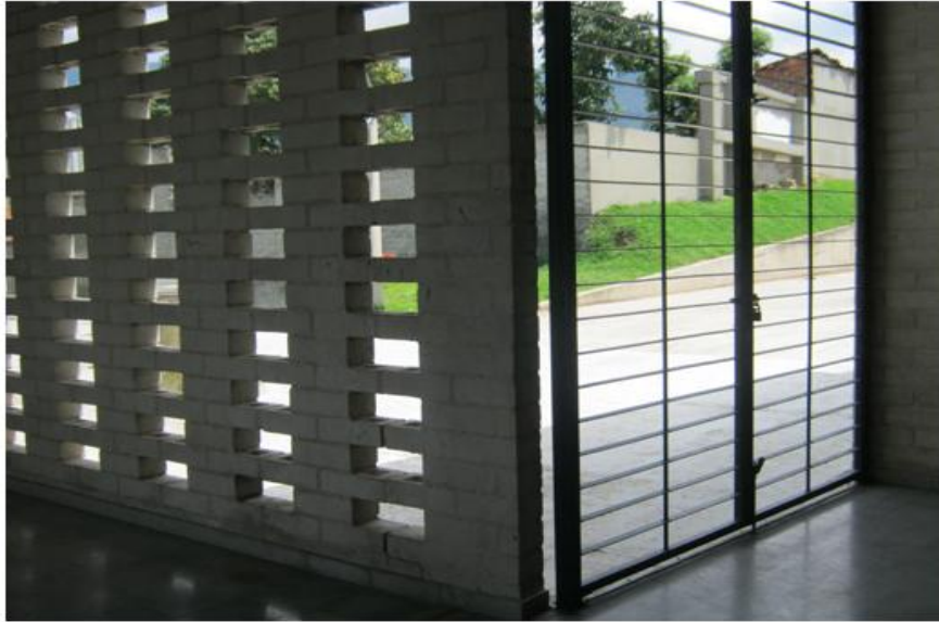
Muro que da la cancha. Institución educativa "La Caja de cristal" 2010
