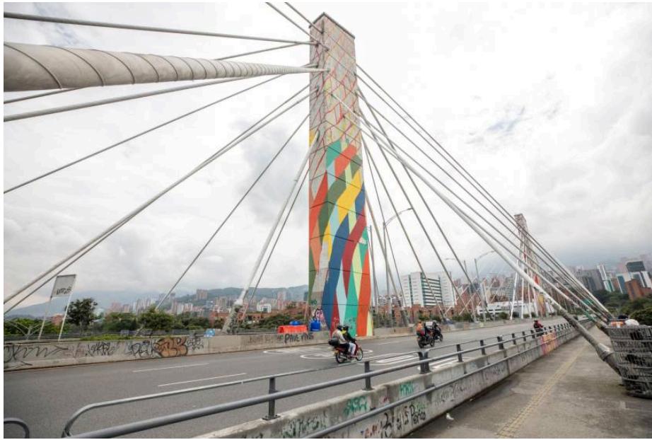
Inicio de Mural del Puente de la 4 Sur
