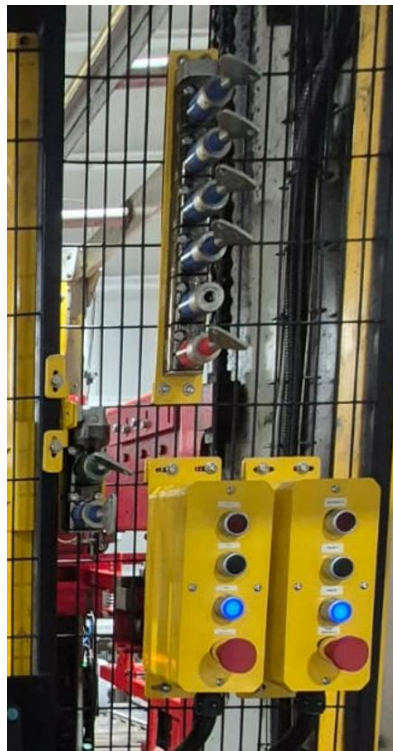
Fig. 105 Montaje de botonera y módulo de llaves
