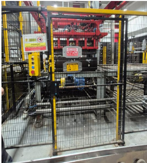
Fig. 101 Montaje dispositivos del acceso 4
