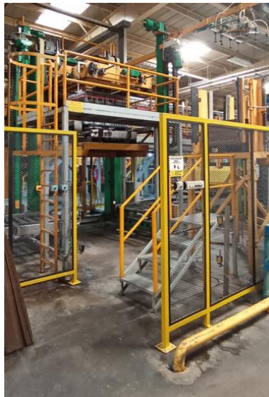
Fig. 9 Punto de acceso no monitoreado
