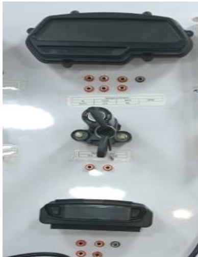
Fig. 15. Tablero Primario y secundario instalados en el tablero.
