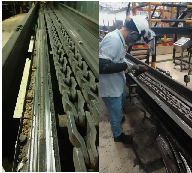
Fig. 25. Suciedad en canales guía de transportes cardánicos y operario de línea realizando labores de limpieza
