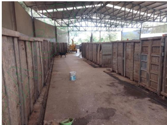
Figura 20 Zona subutilizada con módulos de aireación convectiva
