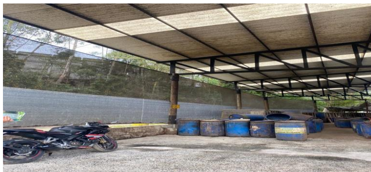
Figura 4 Cerramiento en zona de compostaje
