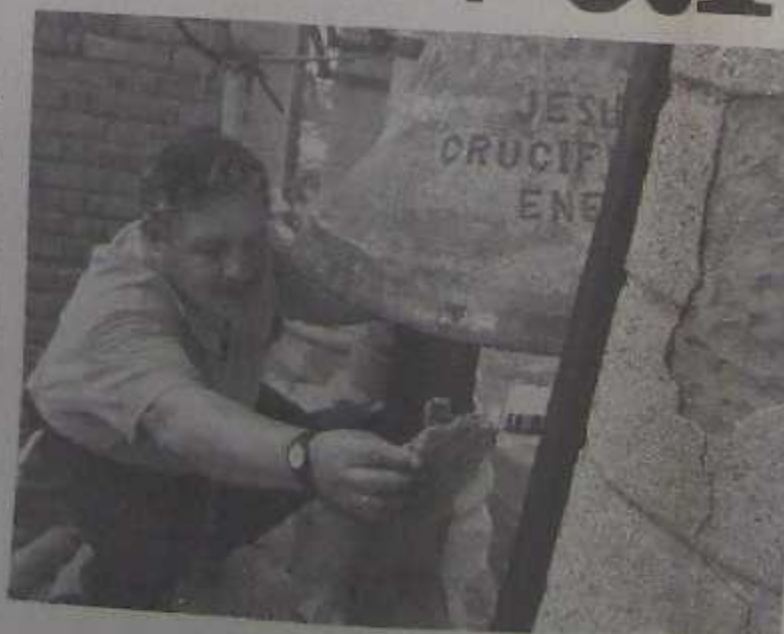
Desafiando la altura, que en ese sitio se traduce en vértigo, el sacristán Os- car González muestra el deterioro de las columnas que sostienen la torre.
