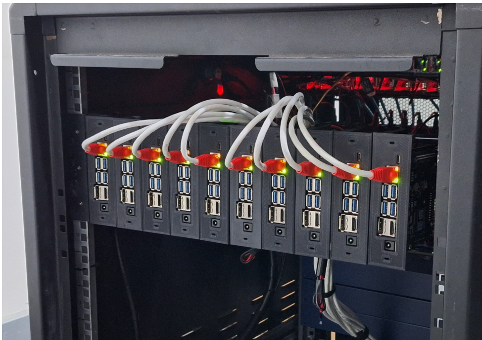
Fig. 14. Montaje final de las diez tarjetas en el sistema de sujeción.
