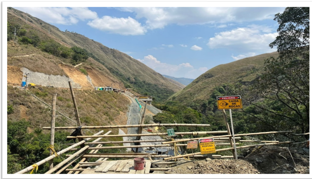
Tramo abierto TGGE
