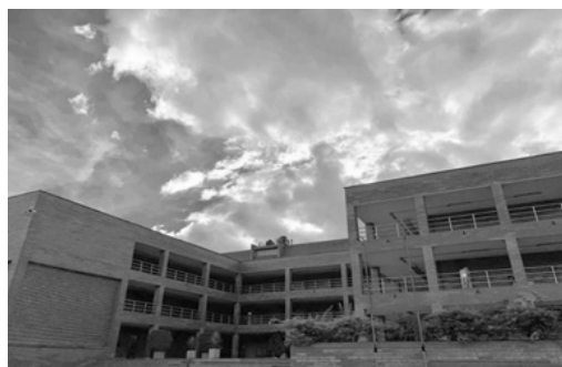
Figura 3.22. Sede de Posgrados de la Universidad de Antioquia.
