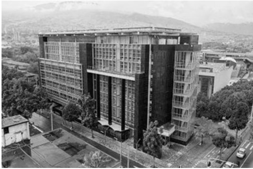
Figura 3.12. Edificio de Extensión UdeA, administrado por la Fundación Universidad de Antioquia hasta 2020.
