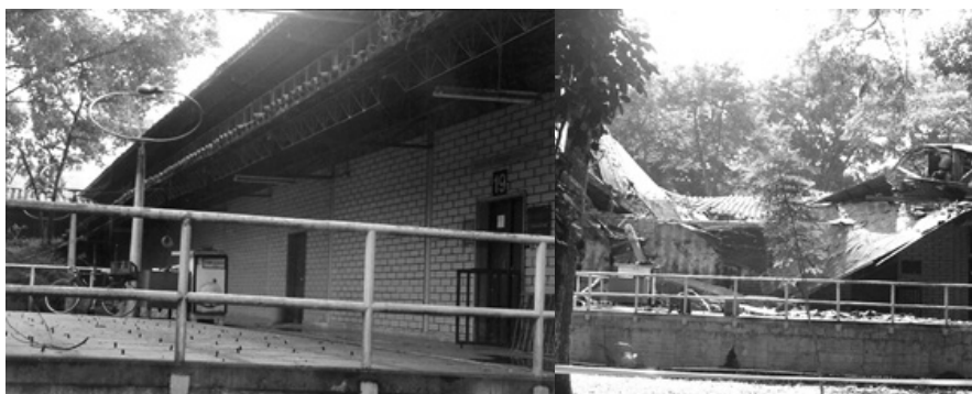
Figura 2.10. y 2.11. Demolición Bloque 19.
