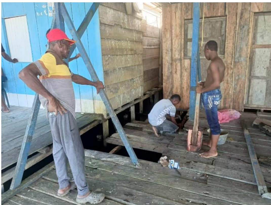
Imagen 27. Reparación de un lavadero artesanal en Marriaga
