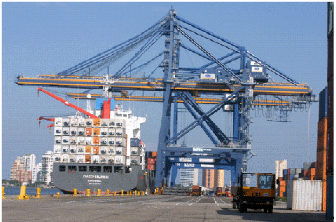
Figura 6. SPRC, vista de la grúa pórtico desde el muelle 7 (SPRC, 2005).
