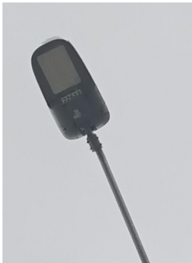
Fig. 3. Luminaria sin etiqueta de potencia
